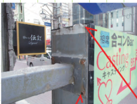
取付けボルト錆 裏板金腐食
